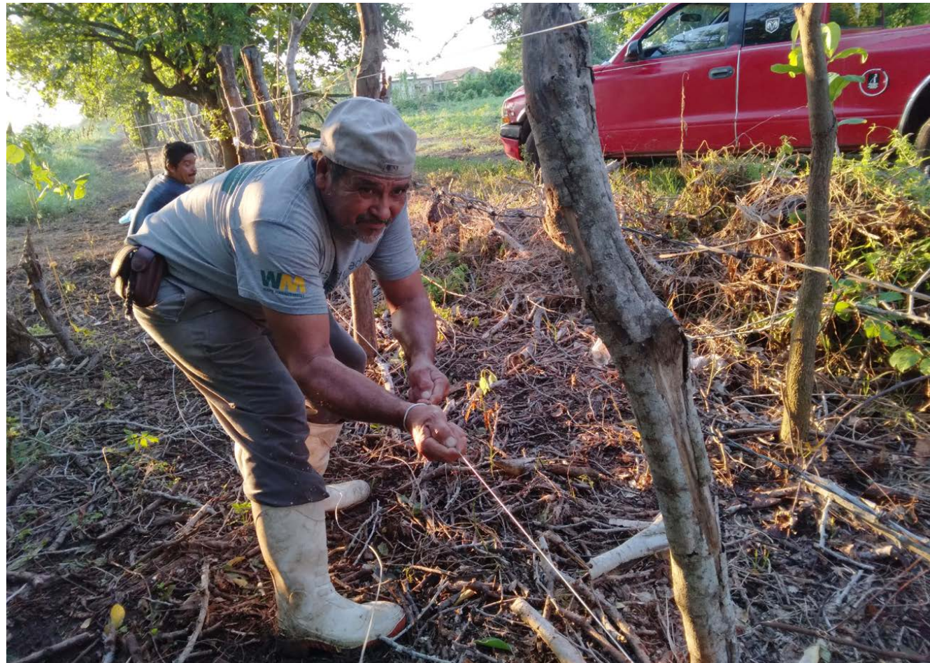
Implementación de cerco eléctrico para disminución de casos de depredación de ganado por felinos silvestres en la RB Marismas Nacionales Nayarit. Fotografías: Gabriela Delgadillo Quezada
