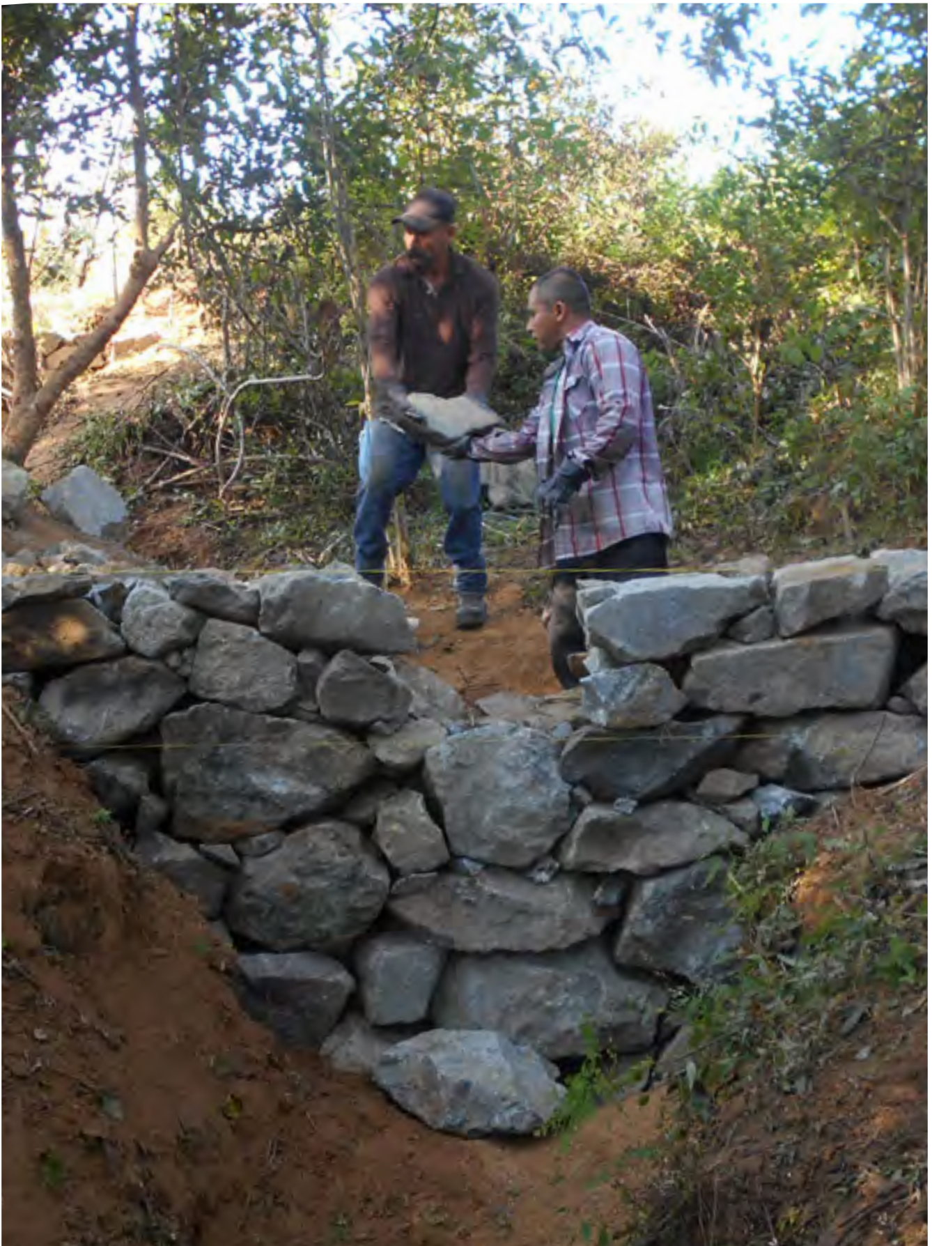
Construcción de represas en la RB Zicuirán Infiernillo. Fotografía: Hugo Zepeda.
