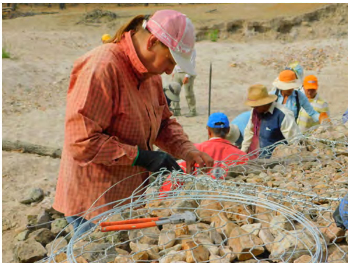
Construcción de presas de Gaviones en el APFF Bavise. Fotografía: CONANP Región Noroeste y Alto Golfo de California.
