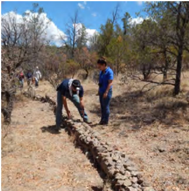
Construcción de bordos en el PN Cumbres de Majalca. Fotografía: Alfonso Prieto Tinoco
