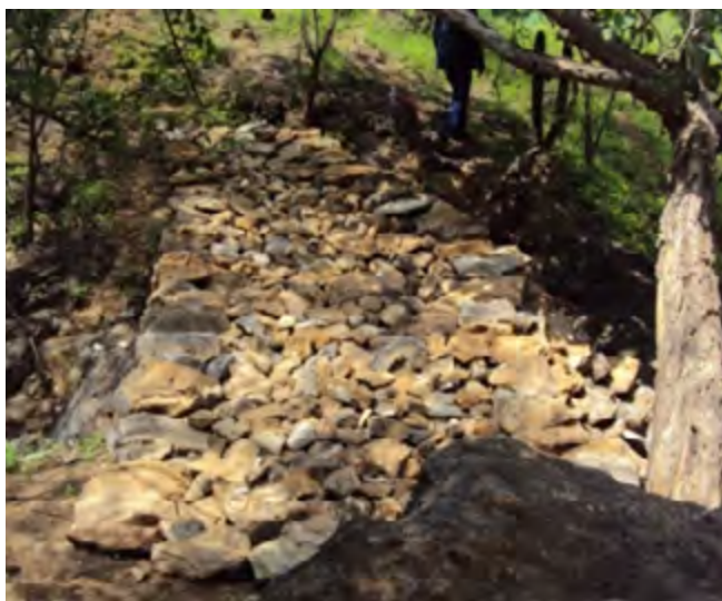
Construcción de represas de piedra acomodada en el APFF Sierra de Álamos Río Cuchujaqui. Fotografía: Dirección Regional Noroeste y Alto Golfo de California
