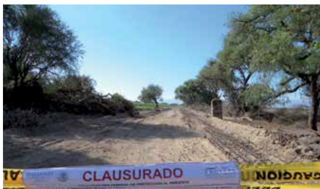
Clausura de construcción de un camino pavimentado en el PN Gogorrón, San Luis Potosí.
