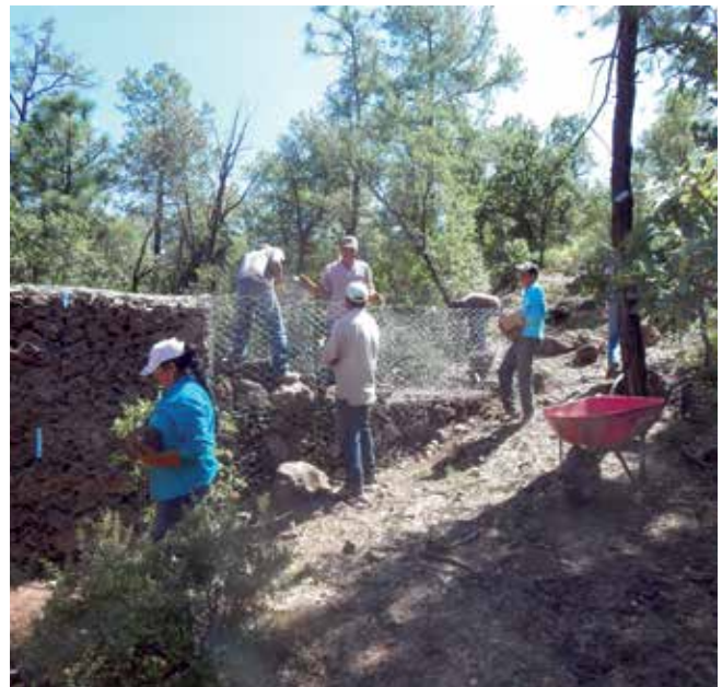
Construcción de gaviones en la RB Janos, Chihuahua. Fotografía: Rogelio Fuentes/Archivo CONANP.
