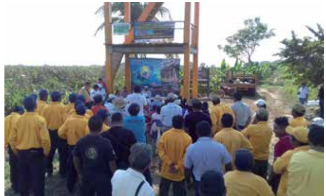
Instalación de torre para detección de incendios en la RB La Encrucijada, Chiapas. Fotografía: Gilberto Cabrera/Archivo CONANP.
