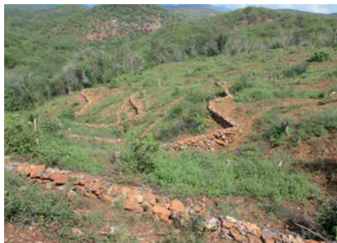
Obras de conservación de suelos en la Reserva de la Biosfera Zicuirán-Infiernillo, Michoacán.
