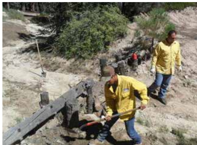
Construcción de 10 obras de conservación de suelo en el Parque Nacional Sierra San Pedro Mártir, Baja California.
