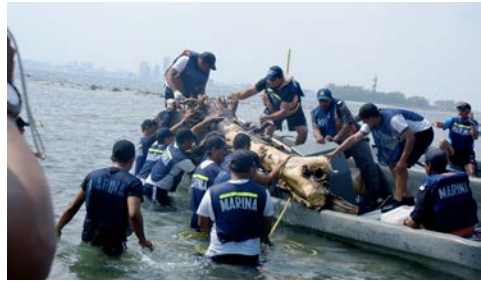
Trabajos de restauración, remoción de "palizada" tras el paso del huracán Karl, en coordinación con personal de la SEMAR.
